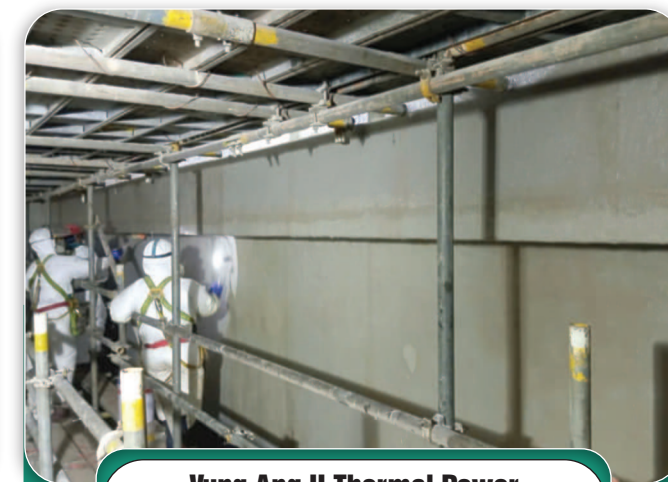
Vung Ang II Thermal Power Plant Project
